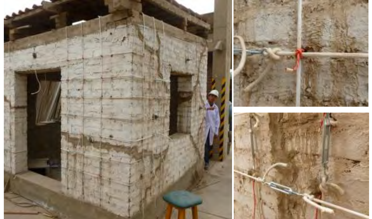
Figuras 4: Reparación de grietas y reforzamiento de muros de adobe con materiales compatibles. Director: Marcial Blondet & Julio Vargas - Tesistas: Jonathan Soto & Carlos Sosa – 2013
